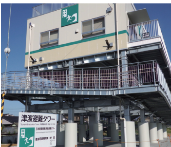
《蓄光タイプ設置例》 仙台市津波避難タワー
